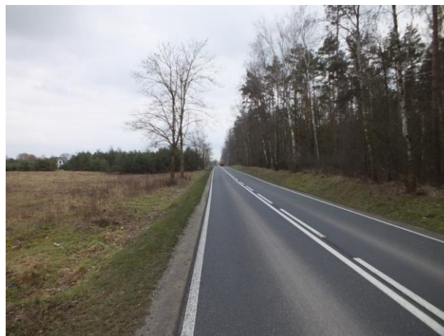
12. Zachodnia część obszaru opracowania – widok na drogę wojewódzką nr 197 w kierunku południowym
