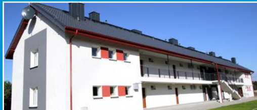
BUDYNEK KOMUNALNY GOTOWY
